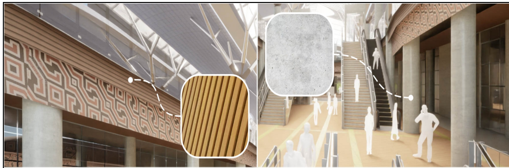
Gambar 10 Penerapan material Wood Plastic Composite (kiri) dan beton ekspos (kanan) Sumber: Penulis, 2023
