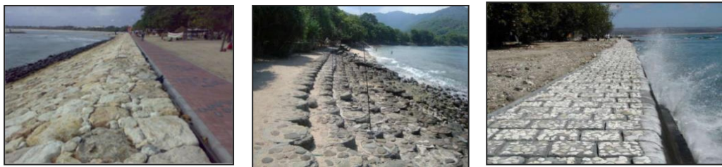
Gambar 2. Ilustrasi Bentuk Penerapan Konsep Revetment
