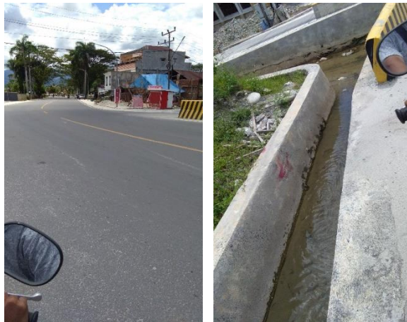
Gambar 3. Pembangunan Kembali Jaringan Jalan dan Jaringan Drainase Pasca Bencana Banjir Bandang
