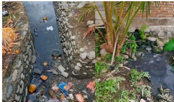
Gambar 11. Kondisi Air Limbah
